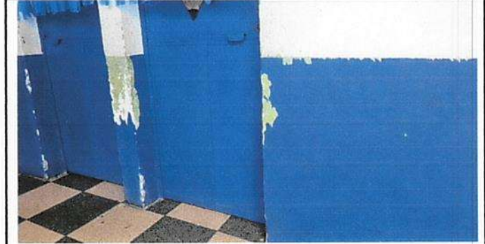
Foto 14: Modulo V Pintura exterior de salones de clases
