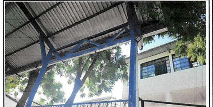
Foto 10: Modulo III CANCHA Reparación del sistema electrico
