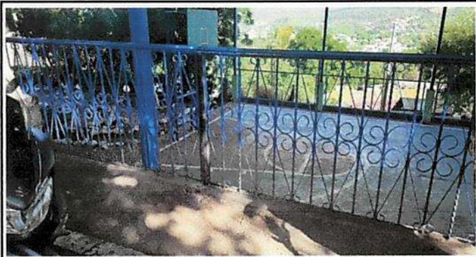
Foto 7: Modulo III CANCHA Reparación de bordillo
