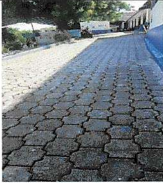
Foto 1: Modulo I PATIO PRINCIPAL: Reparación de adoquín
