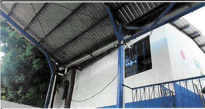
Foto 09: Modulo III CANCHA Reparación sistema electrico
