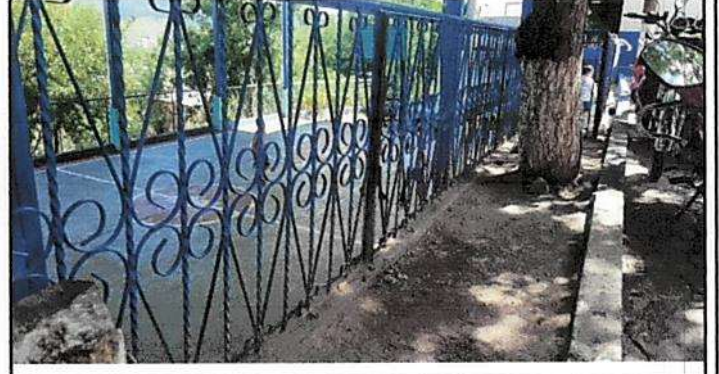
Foto 8: Modulo III CANCHA Reparación de bordillo
